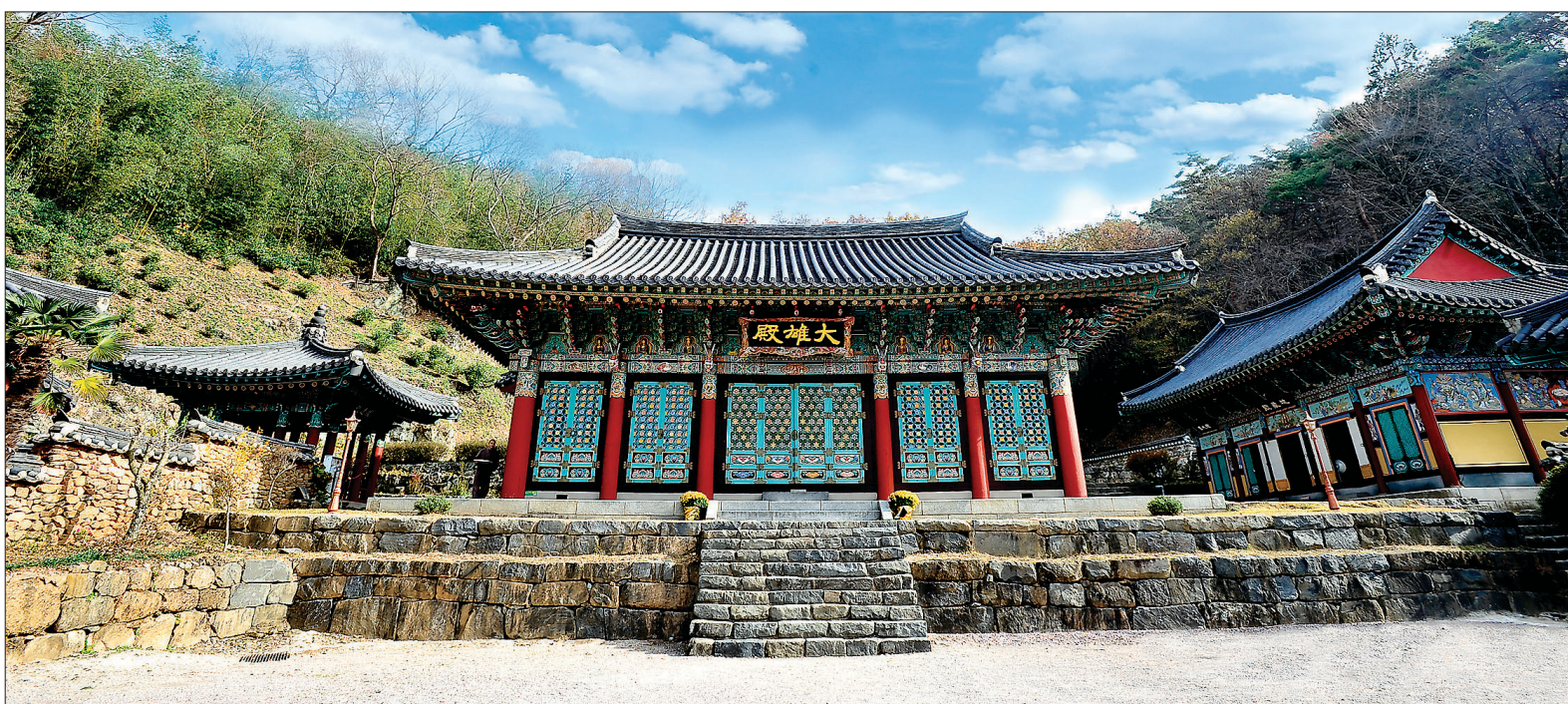
증심사 대웅전 전경 모습. 정면 5칸, 측면 3칸의 다포계 팔작지붕 건물로 한국전쟁당시 불타 것을 1971년 중건했다. 현재 광주광역시 문화재자료 1호다.
