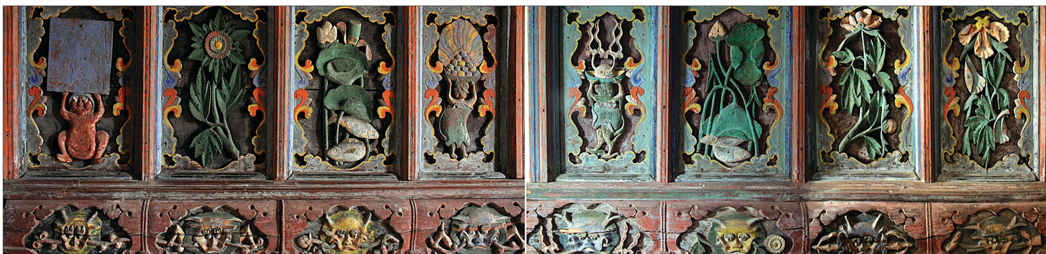
불단 좌우 측면에 각각 4폭씩 배분 장면. 연결하면 8폭의 민화병풍에 손색없다. 사각형의 세계를 들고 있거나 오색의 빛이 흐르는 보주를 공양헌공하는 나찰이 인상적이고, 기단부의 두팔 뽀얀 용의 자세에서 익살과 해학이 넘친다.
