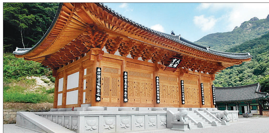
정읍 내장사 대웅전 복원불사 완료 모습. 정면 5칸 측면 3칸의 약 150㎡ 규모에 팔작지붕 형태.
