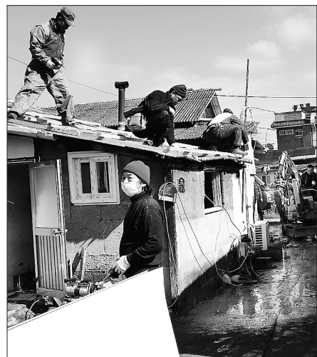
연화재가노인지원서비스센터 결연 사업 중 하나인 주거환경 개선 사업
