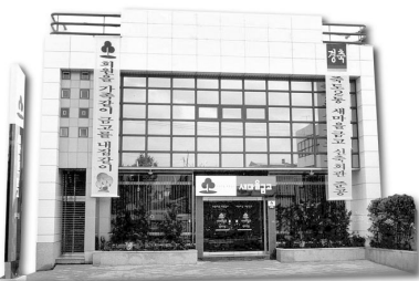
형산새마을금고 본점 전경
