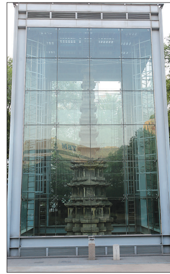
<사진3> 유리보호각 안의 불탑
