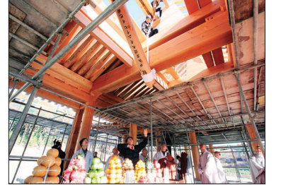
통도사 템플스테이관 상량식 장면
