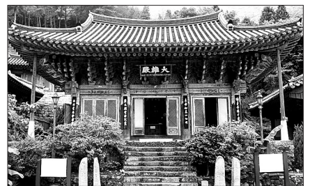
남해 용문사 대웅전은 평면 구성과 공포의 표현기법, 상부 가구와 단집 등에서 수려한 장엄 수법을 잘 간직하고 있으며 이는 18세기 이후 건립된 사찰 주불전의 특징적 건축양식이다.
