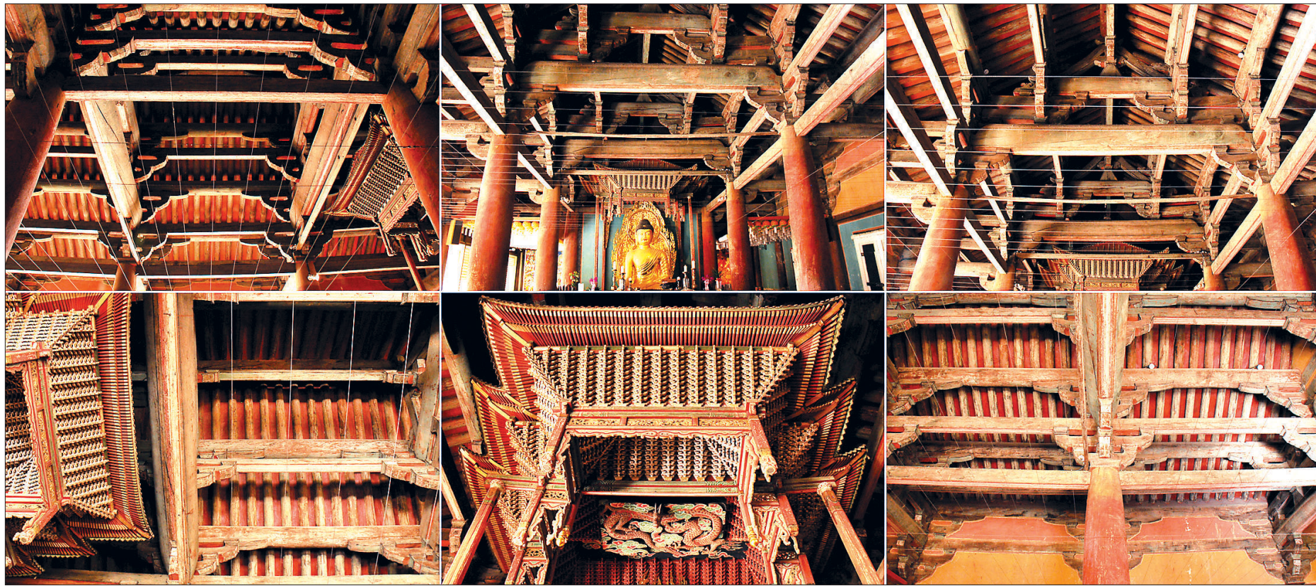
부석사 무량수전 내부. 아미타부처께서 열두 너머의 깊이에 독존으로 계시고, 천정은 가구부재가 노출된 연등천정이다.
