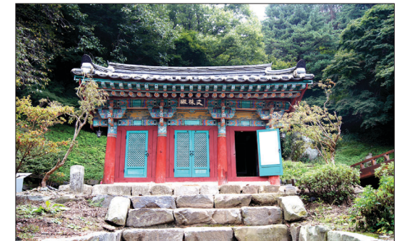
문수기도의 성지인 문수전 전경.
