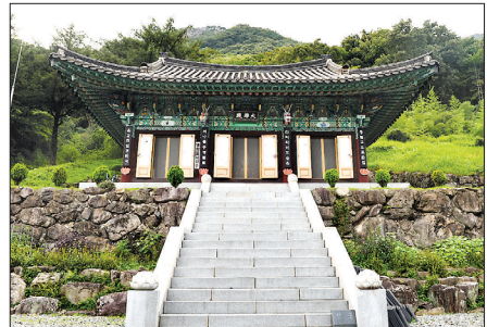
천진암 대웅전 전경
