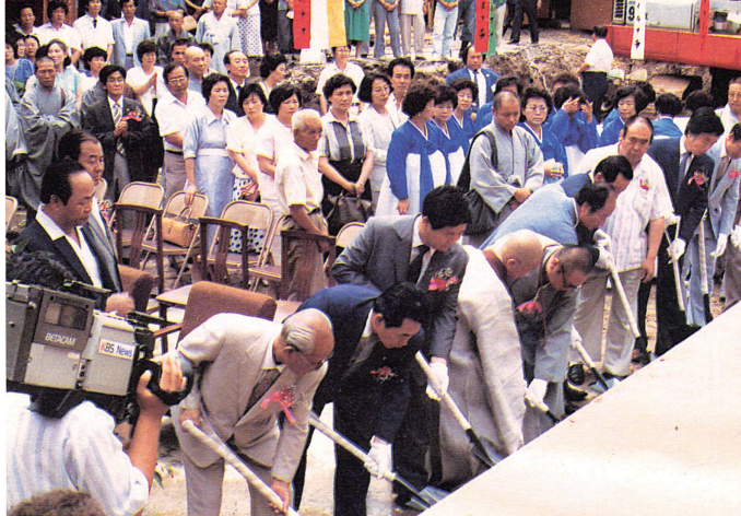
현 법왕청 대법당을 건립하기 위하여 정지작업을 마치고 기공식을 하시는 일봉 큰스님과 문도, 기관장, 각계 불자들이 (1987년)
