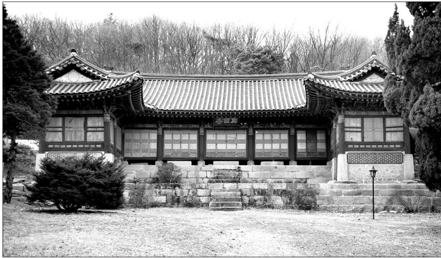
보광 스님이 등록문화재 예시로 든 남양주 흥국사 대방. 정토 염불 사상이 크게 성행하던 근대기의 시대적 상황을 반영한 염불 수행 공간으로 전통방식을 벗어난 근대건축의 성립을 보여준다.
