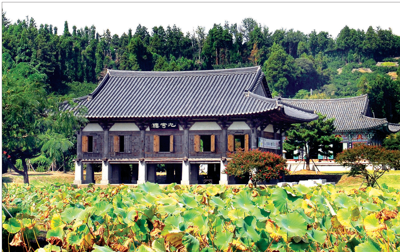
극락정도 구품의 세계관을 상징하는 3천여명의 연지 뒤에 우뚝 서 있는 구화루의 풍광이 빼어나다. 특히 '구품연지'는 발굴 조사결과를 토대로 그대로 복원했다.
