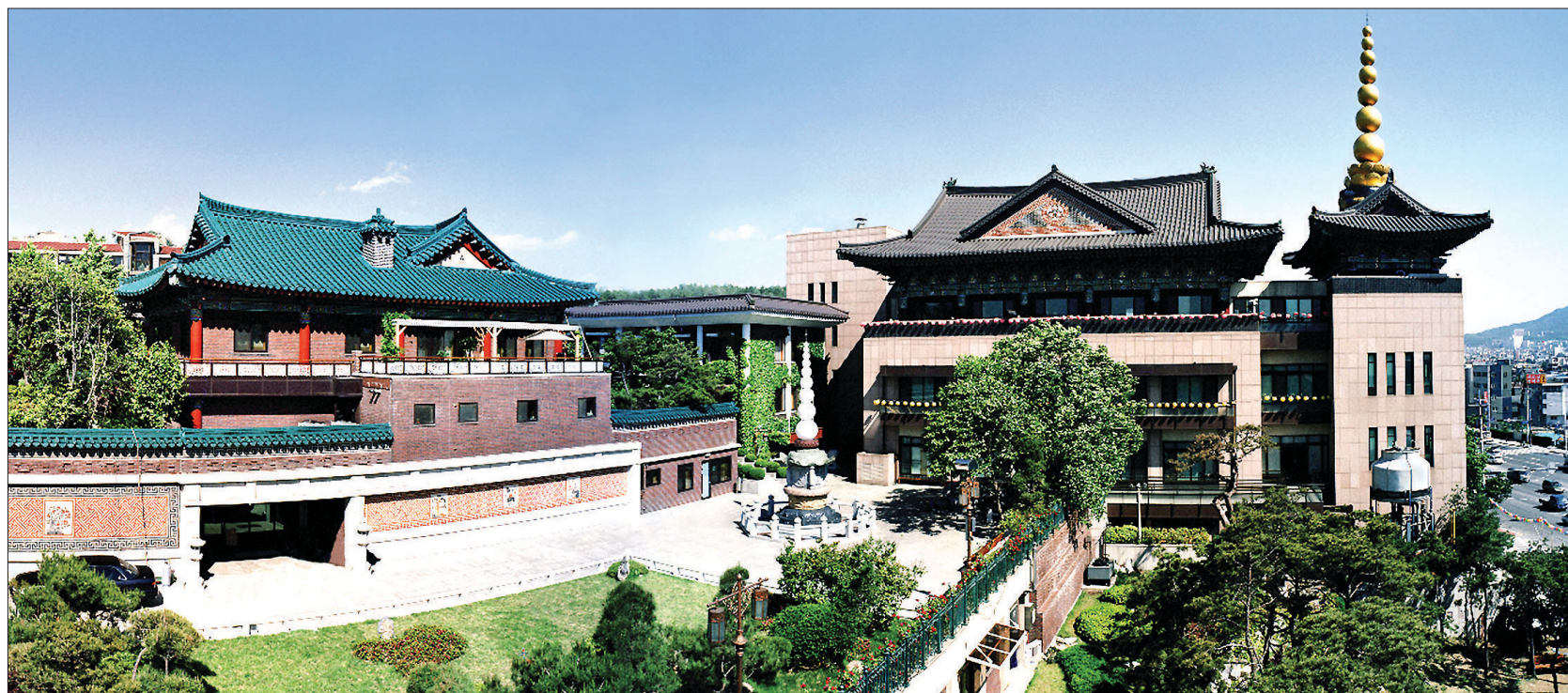
한마음선원 안양 본원 전경. 지하 4층, 지상 5층의 총 9층 규모인 한마음선원은 안양의 랜드마크라고 해도 손색이 없을 정도다. 지붕의 철모탑은 생을, 도량 마당에 있는 구정탑은 멸을 상징한다.
