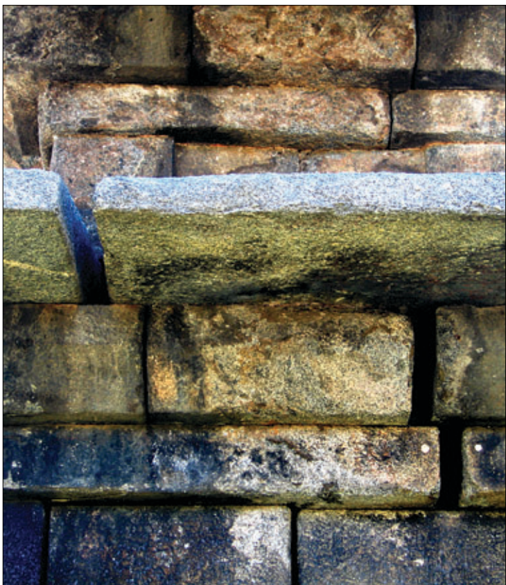
국보 9호 정림사지 5층 석탑(왼쪽 사진). 1층 탑신부에 틈새가 벌어져 붕괴 위험이 제기됐다.(왼쪽 사진)
