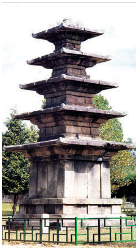
국보 9호 정림사지 5층 석탑(왼쪽 사진). 1층 탑신부에 틈새가 벌어져 붕괴 위험이 제기됐다.(왼쪽 사진)
