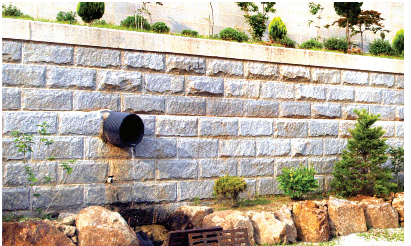
전라북도 사찰에 시공해놓은 석단을 보면 배수를 위해서 설치한 검정색 플라스틱 주름관이 노출된 것을 볼 수 있다. 조금만 더 신경을 썼으면 과거 사찰에서 볼 수 있었던 석루조라는 아름다운 배수시설을 설치할 수 있었을 것이다.
