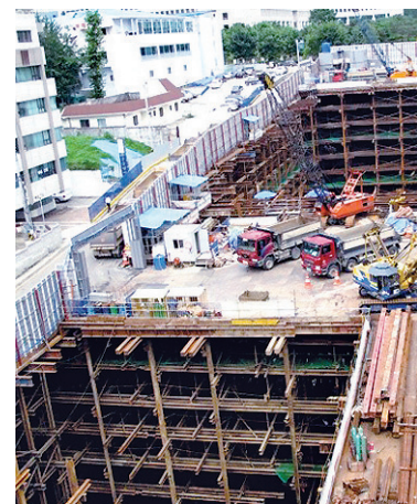
사랑의 교회 신축 공사 현장
