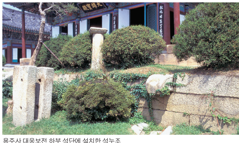
용주사 대웅보전 하부 석단에 설치한 석누조
