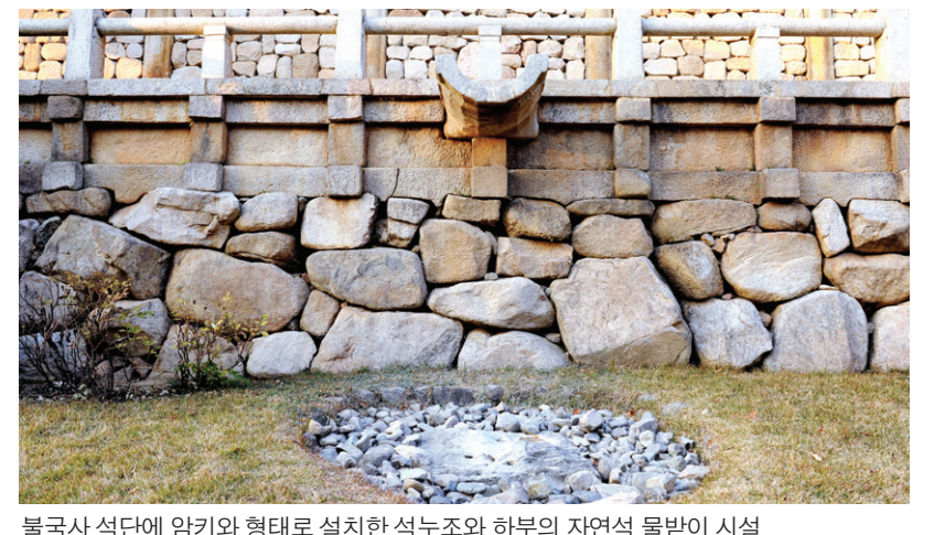
불국사 석단에 암기와 형태로 설치한 석누조와 하부의 자연석 물받이 시설
