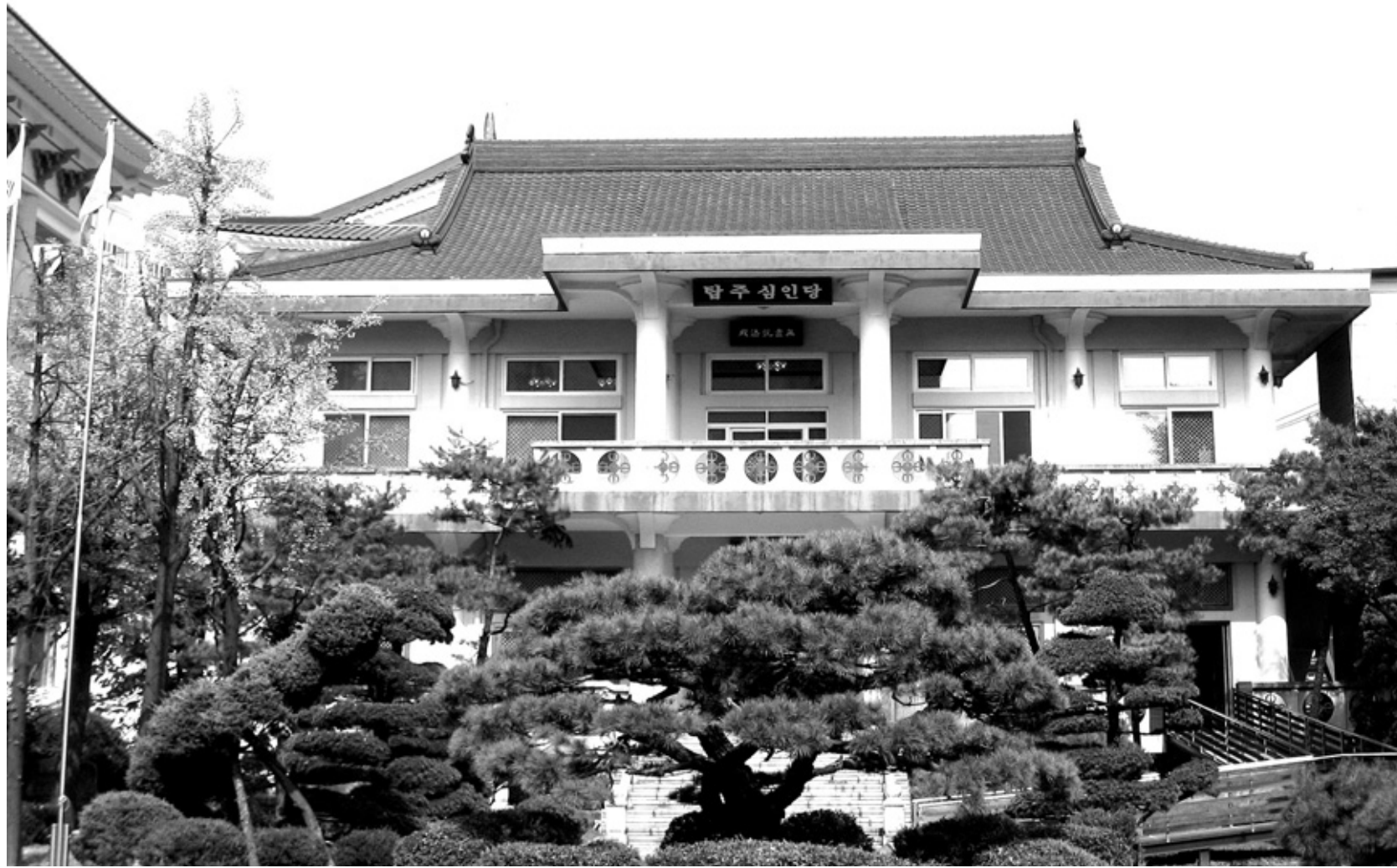
서울 하월곡동에 자리한 진각종 탐주심인당. 심인당은 자신의 마음을 찾는 곳으로 심인은 사람들이 갖고 있는 마음을 뜻한다.
