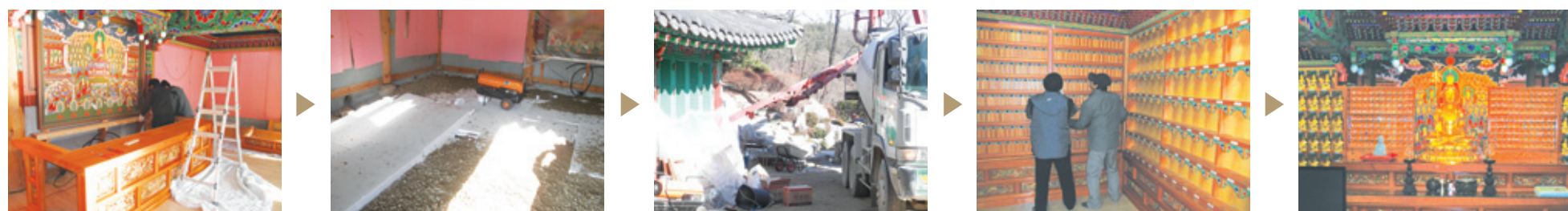
*이송작업 *보강작업 *타설작업 *복원작업 *시공완료
