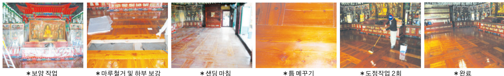
*보양 작업 *마루철거 및 하부 보강 *샌딩 마칭 *틈메꾸기 *도정작업 2회 *완료
