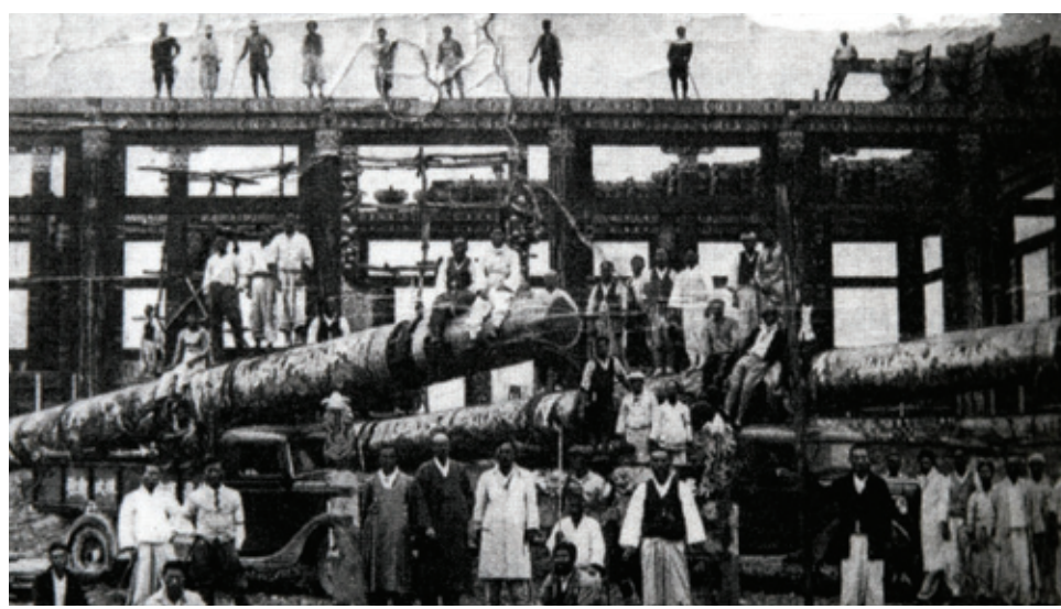
총본산 태고사(現 조계사) 건축공사 장면
