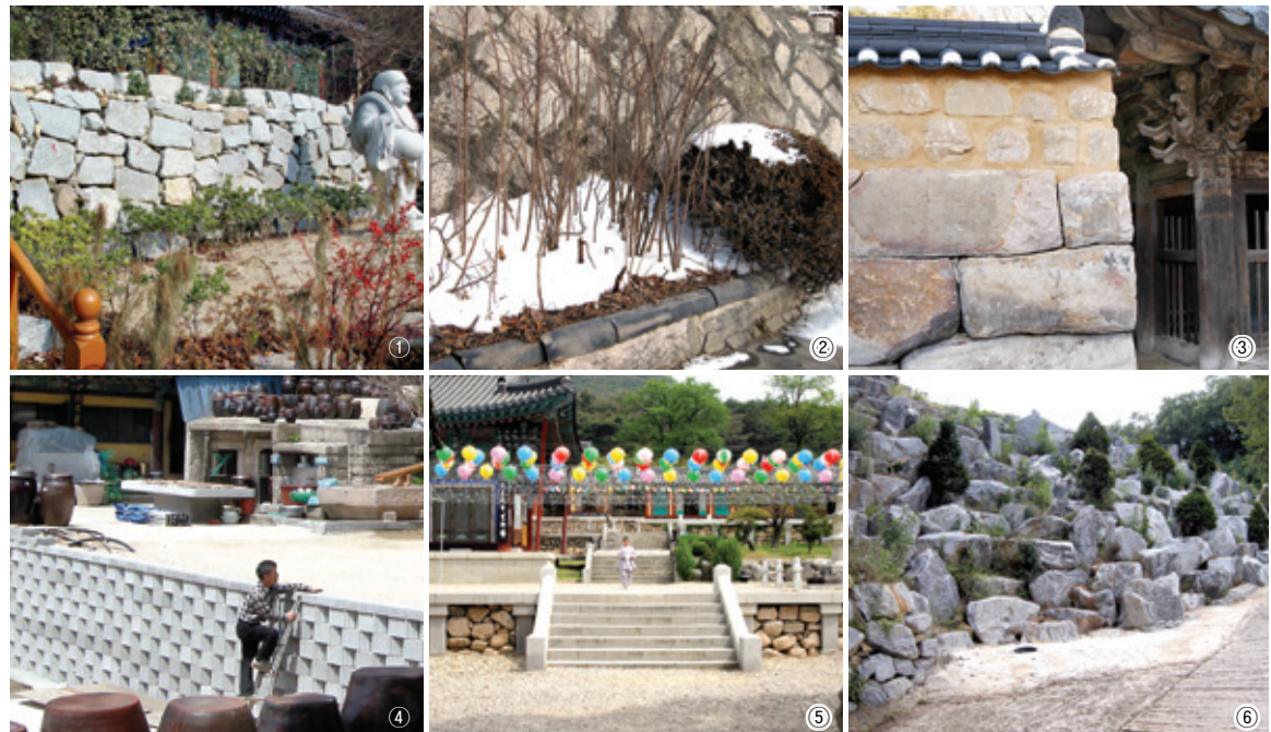
① 발파석을 사용한 석단 ② 일본식 돌쌓기 방식으로 축성한 석단 ③ 전통양식으로 보기 어려운 석단 ④ 전통사찰에 도입된 보강토옹벽 ⑤ 불국사 석단의 아류 ⑥ 무국적 양식의 석단
