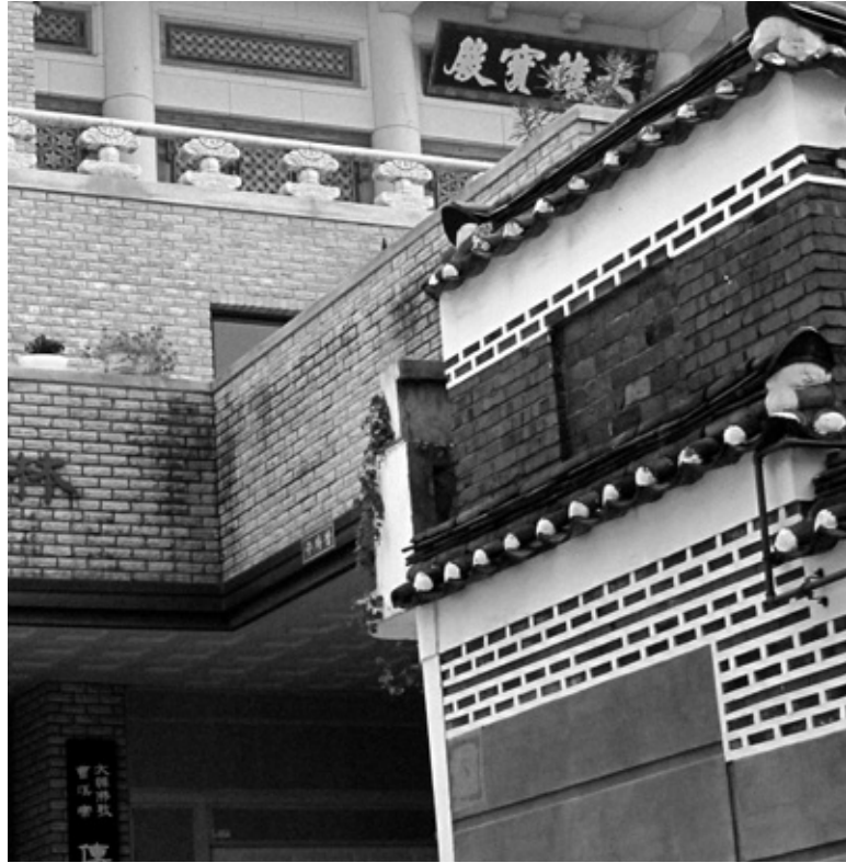
성북 전등사 대웅전은 현대건축과 불교전통이 어우러진 아름다운 건물로 꼽힌다.
