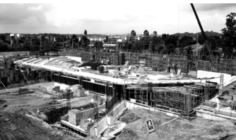
논산 육군훈련소 조국연무사 신축불사현장.
