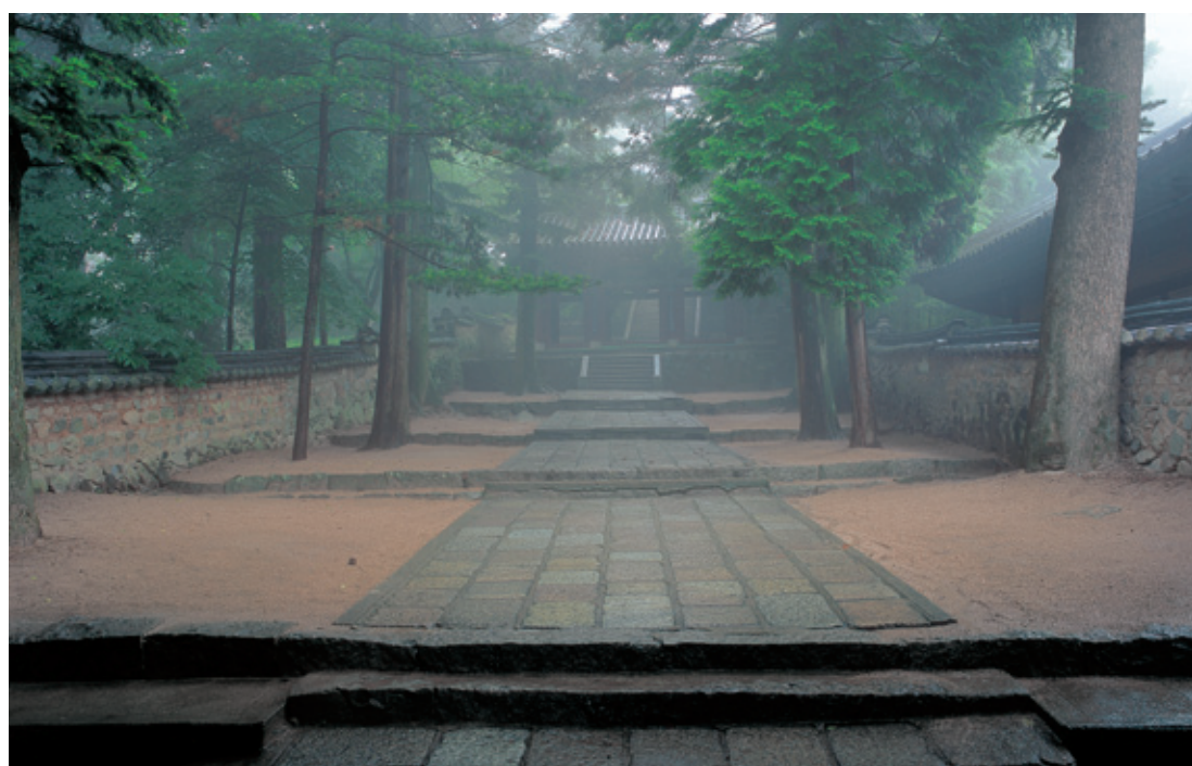
천왕문을 지나 불이문으로 이르는 길은 짧지만 길고, 굽었으니 곧아 보이는 골도 모를 계단이 계속된다. 이 장면은 한국 불교 건축이 성취한 가장 뛰어난 모습으로 한국적 미학의 극치를 보이고 있다. (2010년 12월, 방화로 추정되는 화재로 인한 범어사 천왕문은 전소했다.)
