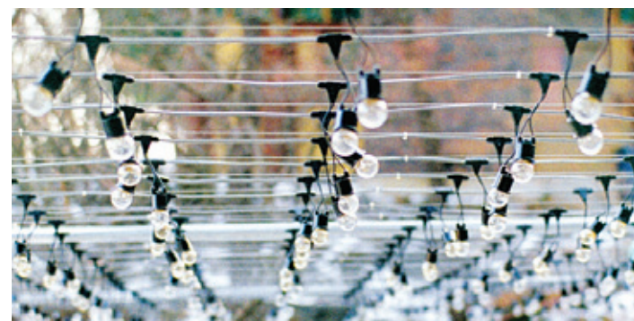
외부에 시공된 전선(케이블)
