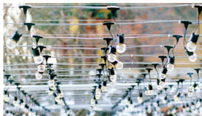
외부에 시공된 전선(케이블)
