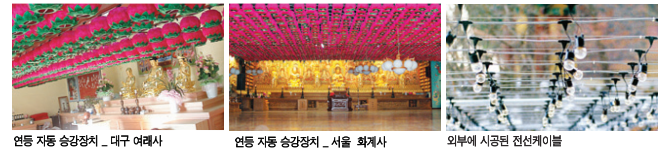
연등 자동 승강장치 _ 대구 여래사 연등 자동 승강장치 _ 서울 화계사 외부에 시공된 전선케이블
