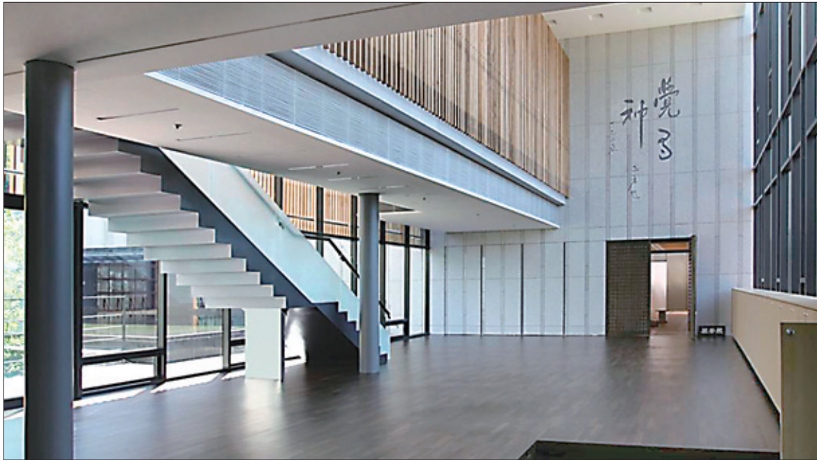
11월 26일 서울 개포동에 개관하는 탄허대종사 기념박물관 내부 모습. 탄허기념관은 전통 사찰의 현대적 해석으로 최근 2010 한국건축문화대상, 서울시 건축대상을 수상했다.
