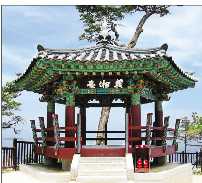
낙산사 의상대 복원 2009년 12월 불교위원회로 해체보수 공사에 들어간 양양 낙산사 의상대가 옛 모습대로 복원됐다. 양양 낙산사(주지 무은)는 6월 22일 ‘낙산사 의상대 단청보수 및 의상대-홍련암간 정비공사’가 마무리됐다고 밝혔다. 당초 낙산사는 의상대 정비공사로 의상대 단청을 세로이 하고 기둥 일부만을 교체하려 했으나 주변 석축붕괴와 해풍으로 인한 기둥 훼손 정도가 심해 4억6000만원을 들여 해체 후 복원공사를 추진했다. 특히 이번 복원공사에서는 일제시대 만들어진 축대돌이 제거되고 자연석으로 교체됐다. 한편, 신라 문무왕 11년(671) 낙산사를 창건한 의상 스님이 좌선하던 곳에 세운 정자로 알려진 의상대는 1925년 만홍 스님이 새로 지었으며 1936년 폭풍우에 무너졌다가 1년 만에 복원된 바 있다. 1974년 강원도 유형문화재 48호로 지정된 의상대는 1995년에도 해체복원공사를 진행했었다. 노덕현 기자 · 사진제공=낙산사
