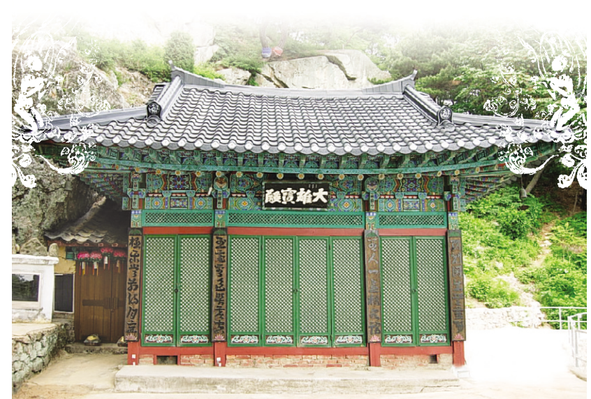
현대 칼라 지붕 공사
