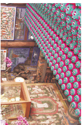
대구 파계사 원불전 천정 전기공사 및 연등 시공
