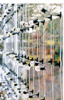
외부에 시공된 전선(케이블)
