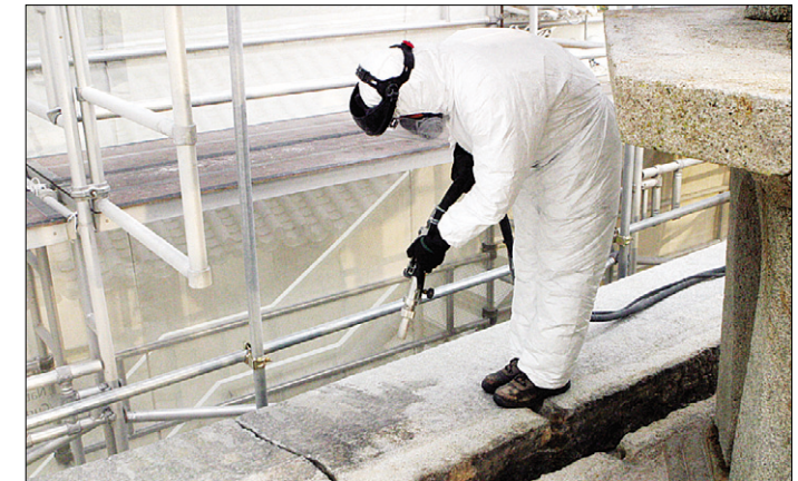
위로부터 시계방향으로 보수된 다보탑 상륜부, 다보탑 전경, 균열된 부재 표면을 세척하는 모습, 균열된 부재를 충전제를 이용해 보수는 모습.
