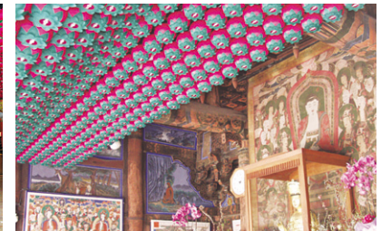
대구 파계사 원통전 천장 전구공사 및 연등 시공
