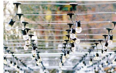
외부에 시공된 전선(케이블)
