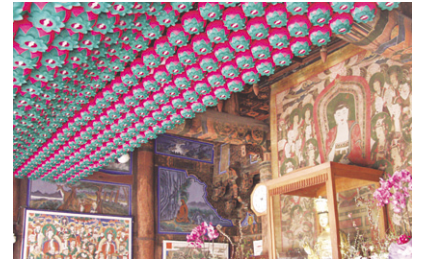
대구 파계사 원통전 천장 전기공사 및 연등 시공
