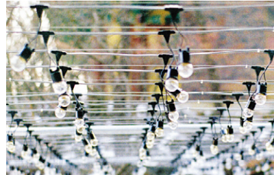
외부에 시공된 전선(케이블)
