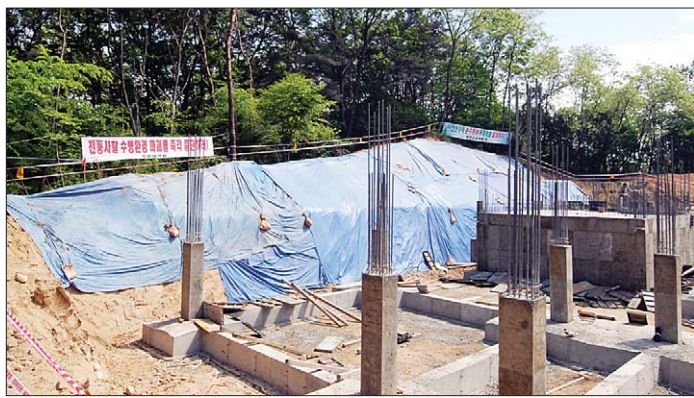
옥천 대성사 인근 금강물환경연구소 공사현장.
