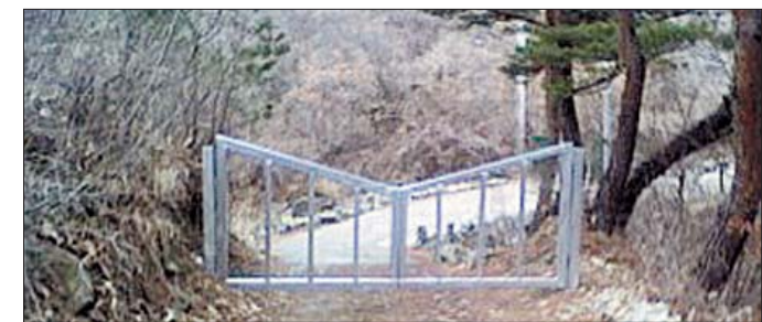
청하사를 통하는 유일한 입구를 가로막고있는 철골구조물. 이것외에 다리 위 구조물과 담장이 더 있다.
