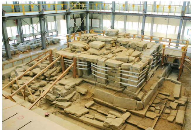
해체보수공사 중인 국보 제11호 익산 미륵사지 석탑.
