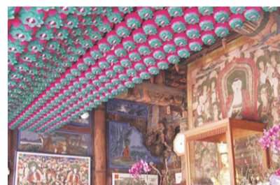
▷대구 피계사 원통전 천장 전기공사 및 연등 시공
