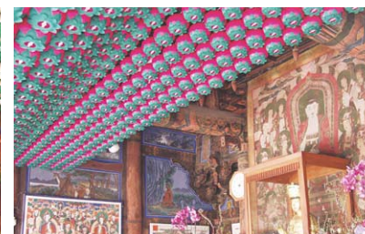
대구 파계사 원통전 천장 전기공사 및 연등 시공
