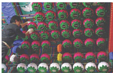
연등 설치 작업
