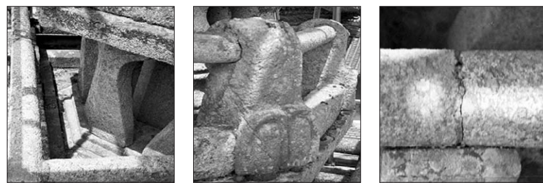
풍화 등으로 훼손이 심각한 다보탑. 이끼에 덮여 훼손된 모습과 난간에 균열된 모습들(왼쪽부터).
