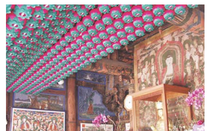
▷대구 피계사 원통전 천장 전기공사 및 연등 시공
