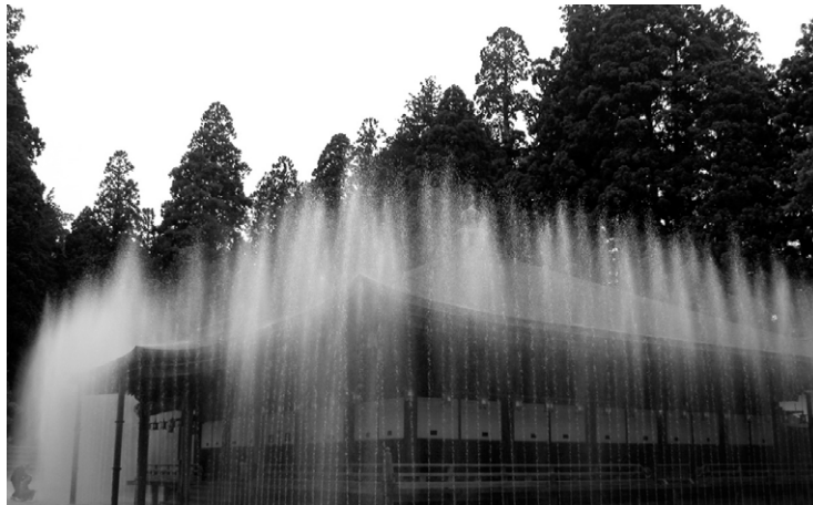
일본 고야산 단상가람 어영당의 상향식 수막 시스템의 작동 모습. 국내 사찰 목조건축물에도 수막 설비를 응용·적용하는 시도가 진행 중이다.
