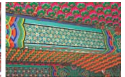
▷연등 설치 후
