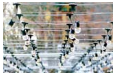
▷외부에 시공된 전선(케이블)
