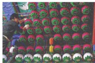
▷연등 설치 작업
