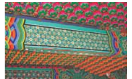
▷연등 설치 후
