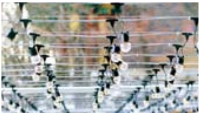
외부에 시공된 전선케이블
