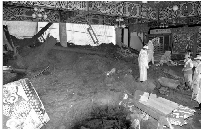
기습 폭우로 인한 산사태로 무너져 내린 평창 천태종 진강사 원통보전.
