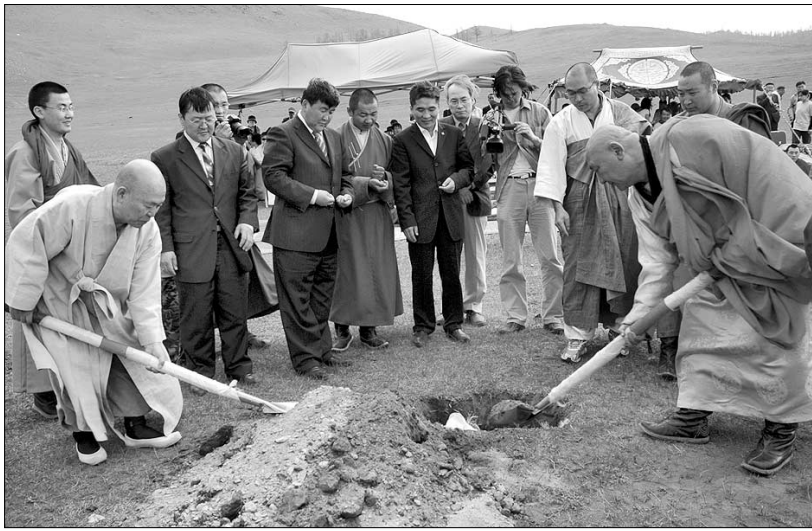
한몽불교교류협회 이사장 지성스님(맨 왼쪽)이 몽골 울란바토르시 3000평 대지에 들어서는 몽골 최초의 한국불교계 유치원 기공식에서 첫 삽을 뜨고 있다. 사진제공=한몽불교교류협회
